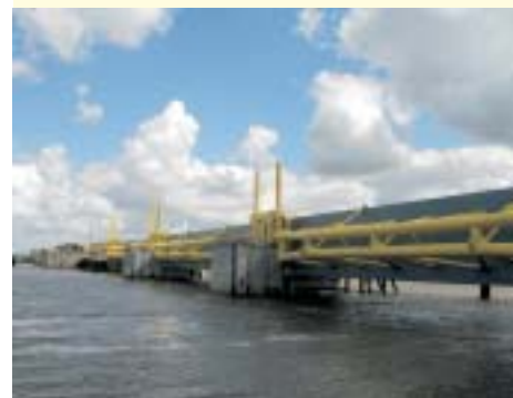
Barrage de protection contre les crues, Emssperrwerk
