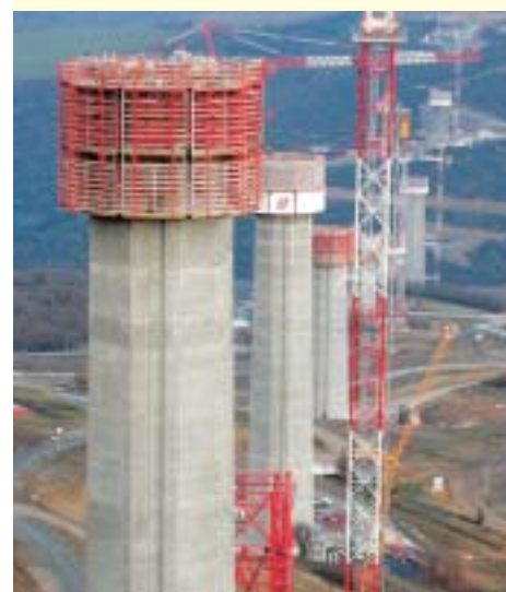
Chantier du viaduc de Millau, Aveyron
