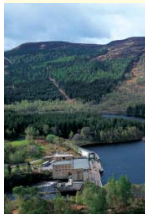
Centrale hydroélectrique, Torrachilty (Écosse)
