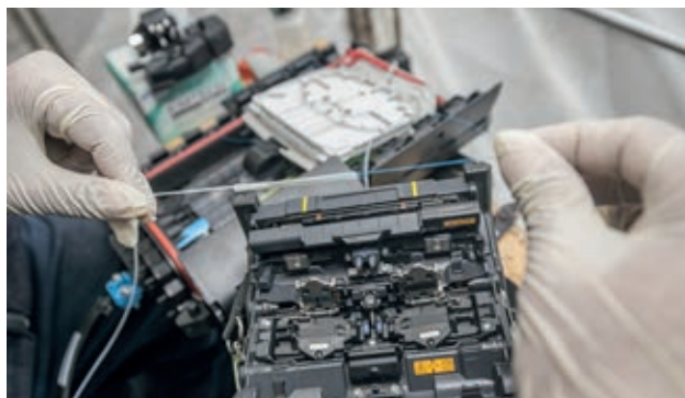
Expansion du réseau d'accès ouvert à fibre optique du promoteur en Irlande.
