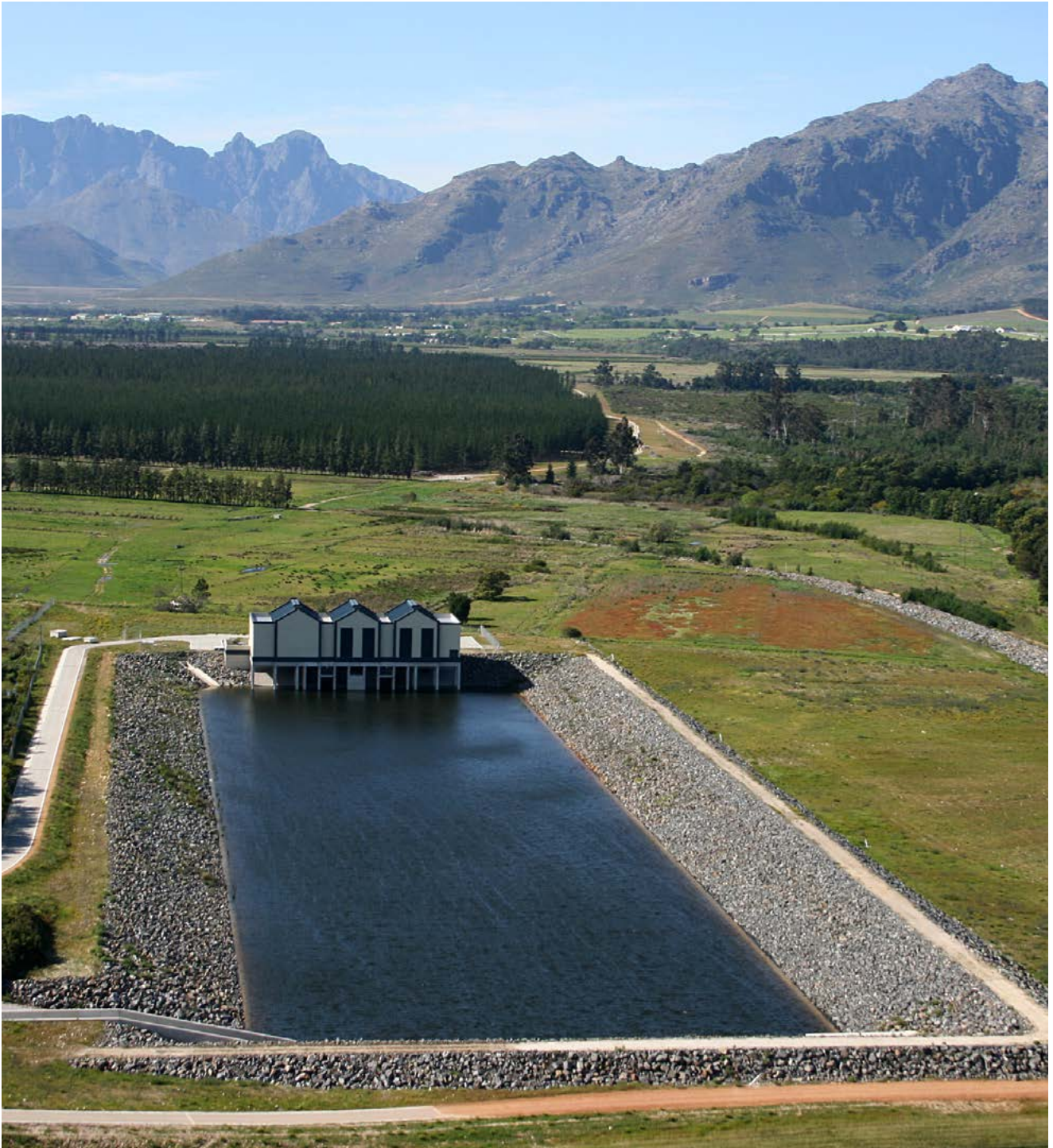
Ein Staudamm am Berg River verbessert die Wasserversorgung für 3,2 Millionen Menschen in Kapstadt (Südafrika)
